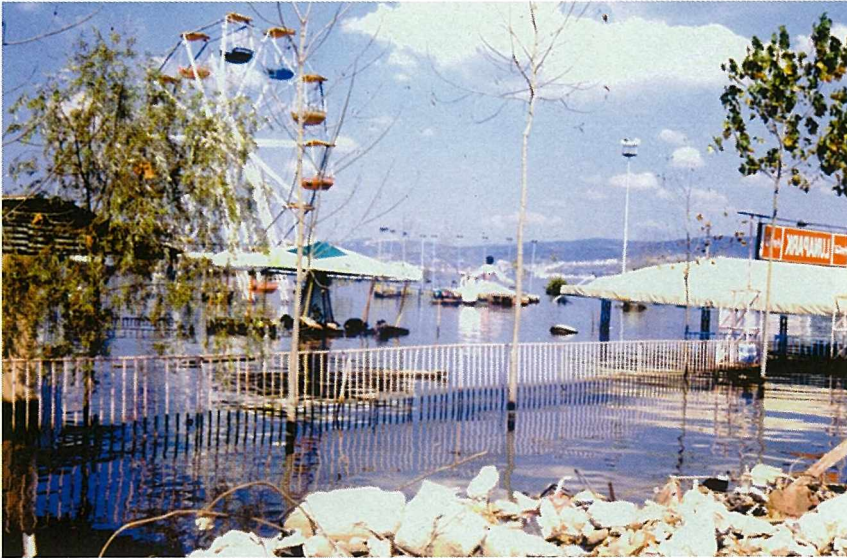
17 Ağustos 1999 Depremi sırasında oluşan yanal yayılma; yığlıkların denize doğru hareketi, Gölcük (Fotograf: Adil Bina)
