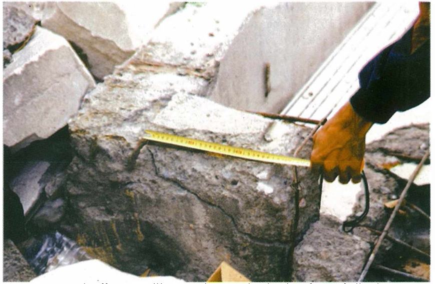
Depreme dayanıklı yapı yönetmeliklerine uygun olmayan yapı elemanları na bir örnek (Fotoğraf: Adil Binal)
