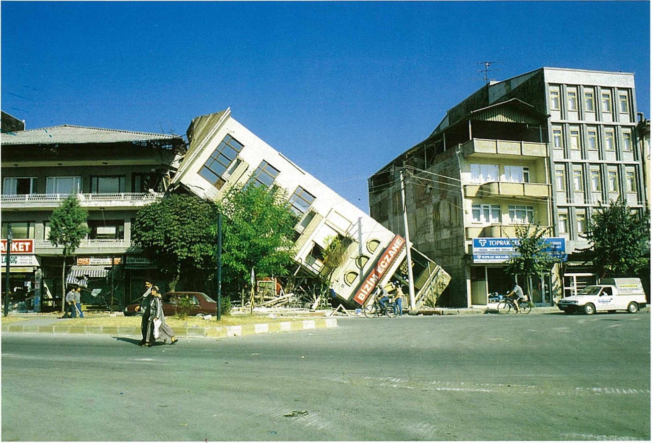
17 Ağustos 1999 Depremi sırasında sivilaşma sonucu oluşmuş yapı hasarı, Adapazarı II Merkezi (Fotograf: Hamdi Mengi)
