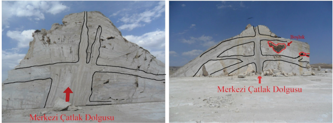
Şekil 10. Taş ocaklarında traverten sırtlarının enine kesitleri. Bunlardan biri Tazekent köyü güneyinde ve diğeri ise Dibek köyü kuzeydoğusunda traverten ocağı yarmalarıdır. Merkezi açılma çatlaklığı, tali çıkış kanalları ve kanatlardaki boşluklar görülmektedir
