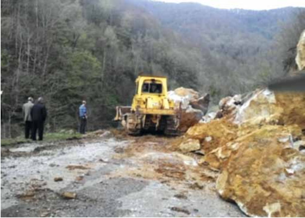
Yol açma çalışmaları
