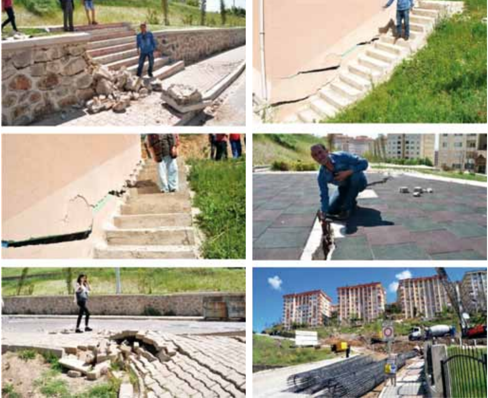
Heyelan nedeniyle meydana gelen yapısal çatlaklar ve hareketi durdurmak için yapılan fore kazık uygulaması
