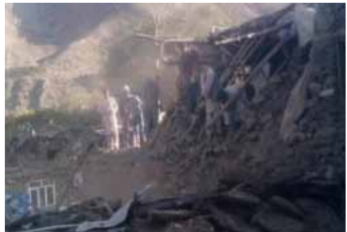
Dayanaksız yapılar depremde hemen çöktü
