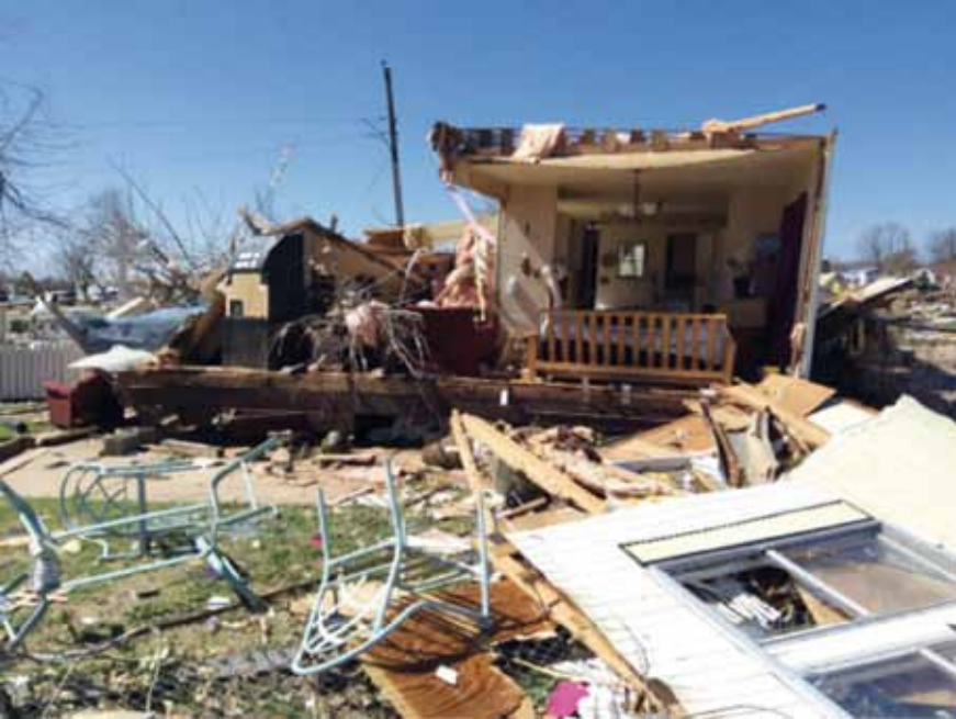
Oklahoma, Sand Springs'te EF2 kategorisindeki hortumda yıkılan mobil ev
