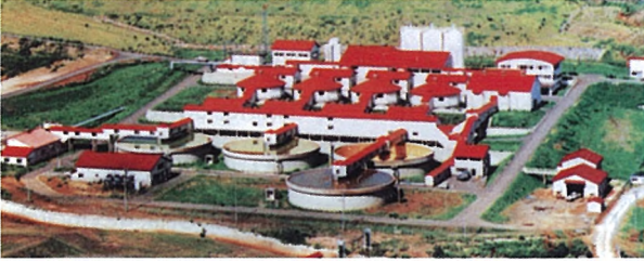
Şekil 2. Matsuo Nötürleştirme Tesisi, Iwate, Japonya.
