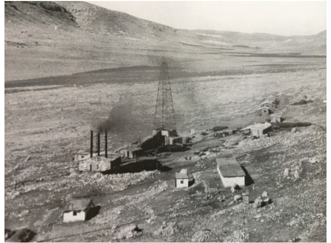
Şekil 5. Raman yapısını test etmek üzere Maymune Boğazı mevkiinde delinen Raman-1 sondajı [11]. Bu sondaj, Türkiye'nin ilk ciddi petrol emareli kuyusudur
