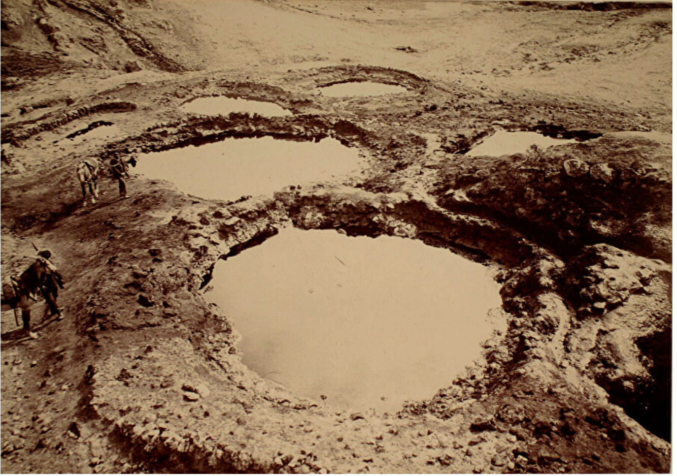
Şekil 2. 19. Yüzyıl sonu, 20. Yüzyıl başlarında Tuzhurmato (Musul) petrol yataklarındaki petrol üretimi yapılan çukurlar (gzt.com'dan alıntı). Çukurlar petrol sızıntıları vasıtasıyla yüzeye ulaşan ham petrolün birikmesini sağlamak üzere oluşturulmuş olmalıdırlar.
