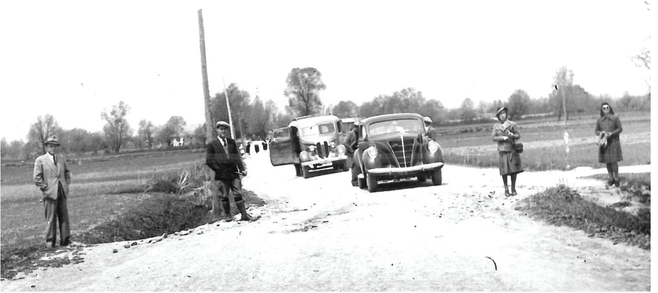
Şekil 4: 1944 Bolu-Gerede depremi sonrasında arazide. Meydana gelen sağ yanal atımlı fayın Bolu yakın güneyindeki görünümü. Fotoğrafta 3.5 m'lik yanal atım üzerinde duruyorlar (6).
