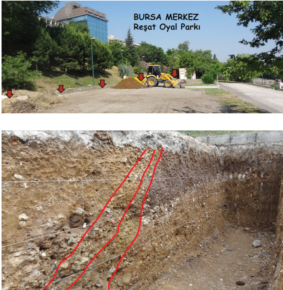
Şekil 4. a) Bursa Fayı'na ait Bursa Segmenti üzerinde şehir merkezinde açılan Bursa Hendeği (bakış yönü batıdır, kırmızı oklar olası diri fay uzanımına ait morfolojik çizgiselliği işaret etmektedir), b) Bursa Hendeği doğu duvarından bir görünüm. Kırmızı çizgiler Holosen yüzey kırıklarını (normal fay) göstermektedir.
