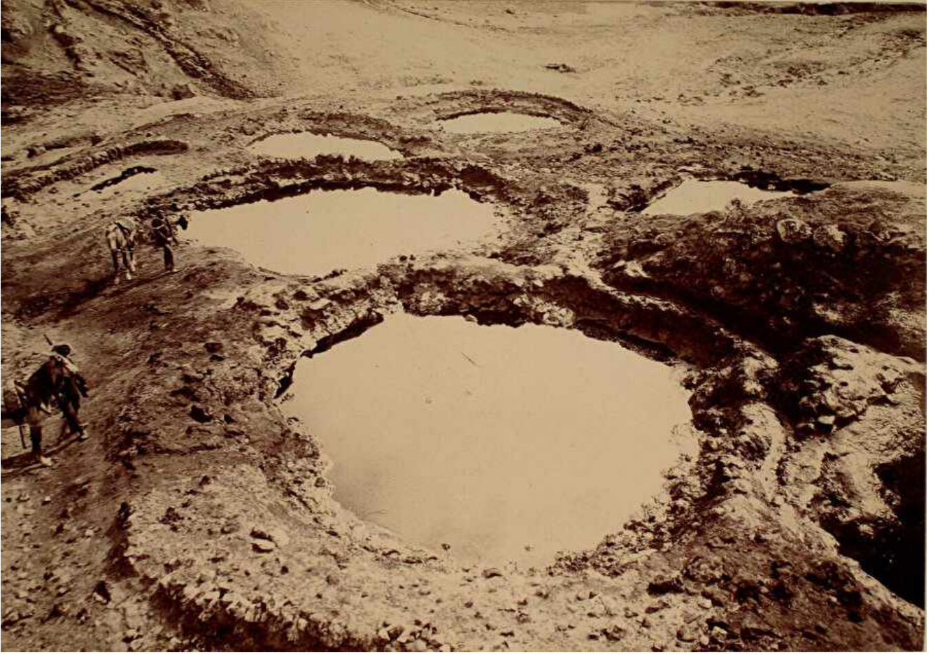
Şekil 2. 19. Yüzyıl sonu, 20. Yüzyıl başlarında Tuzhurmato (Musul) petrol yataklarındaki petrol üretimi yapılan çukurlar (gzt.com'dan alıntı). Çukurlar petrol sızıntıları vasıtasıyla yüzeye ulaşan ham petrolün birikmesini sağlamak üzere oluşturulmuş olmalıdırlar.
