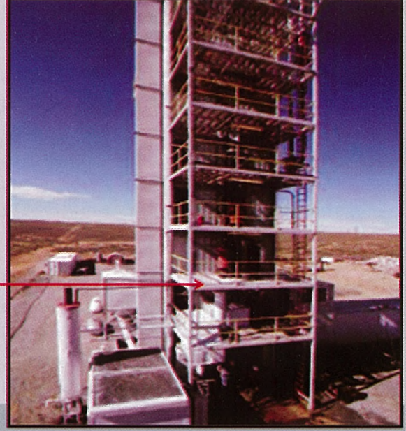
Şekil-4. Shell Petrol Şirketinin ABD-Colarado-Piceance Havzasında petrollü şeyllerden yerinde (in-situ) retortlama yöntemi ile petrol üretiminden bir görünüm.
