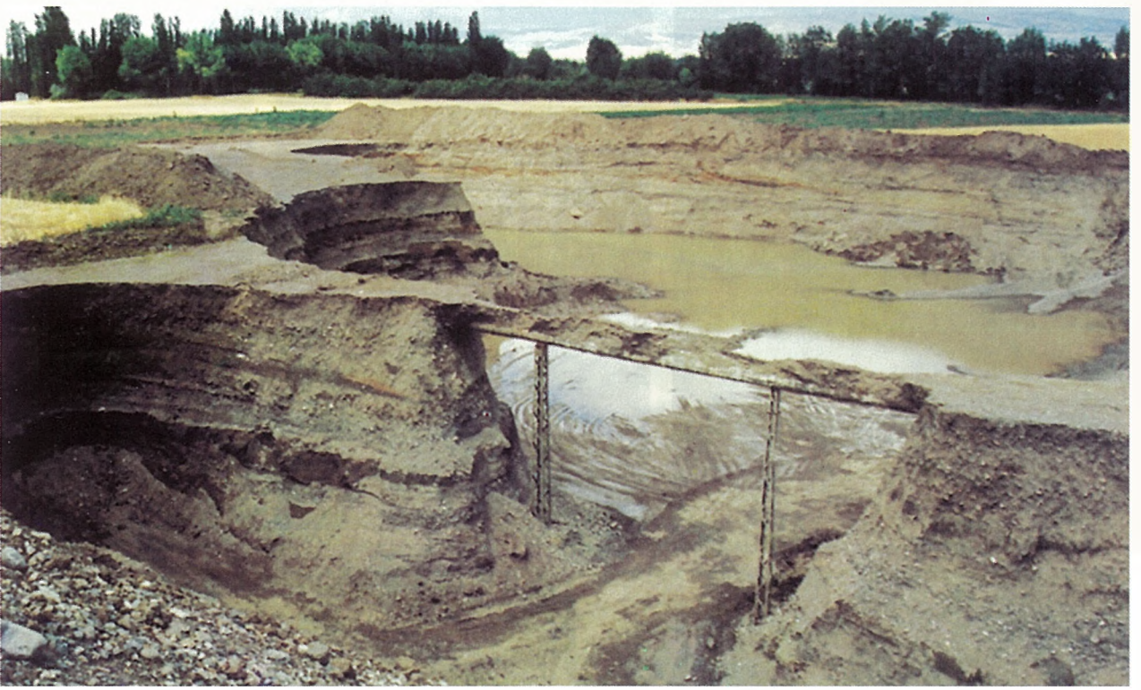
İçören Köyü (Kazan-Ankara) yakınında, akarsu yatağı dışında alüvyon akiferin kazılması sonucu, civarda bulunan ve Ankara'ya içme suyu sağlayan kuyuların iletim borularının açığa çıkması. Borular, ocak işletmecisi tarafından dikilen demir direklerle şimdilik ayakta durabiliyor.
