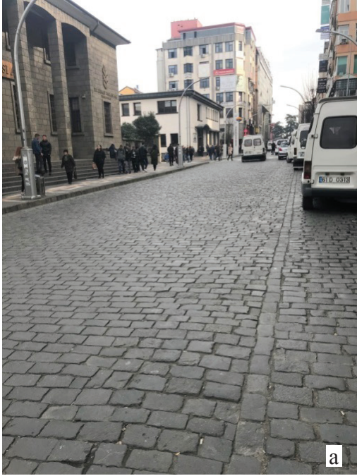
Şekil 6: Trabzon Grisi'nden üretilen kaldırım taşları, bordürler ve plakalar.
