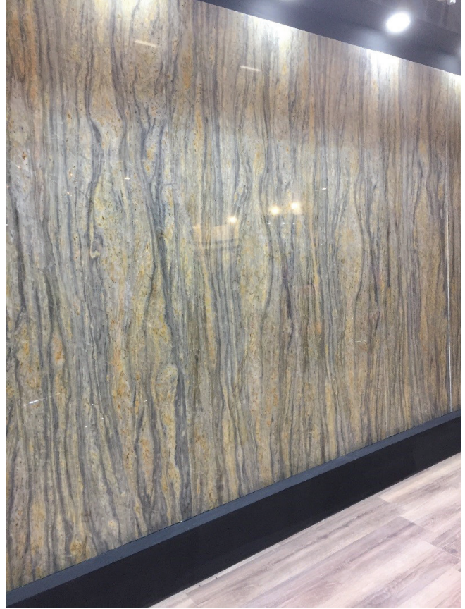
Şekil 3: Bu sektörde taşların görkemini artırmanın en iyi yöntemlerinden birisinin aynı bloktan çıkarılan geniş yüzeyli levhalar üretmek olduğu ifade edilmektedir.
