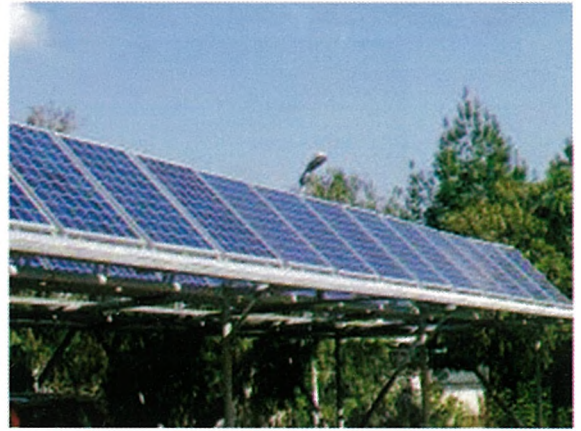
Ege üniversitesi- 24 kWp
