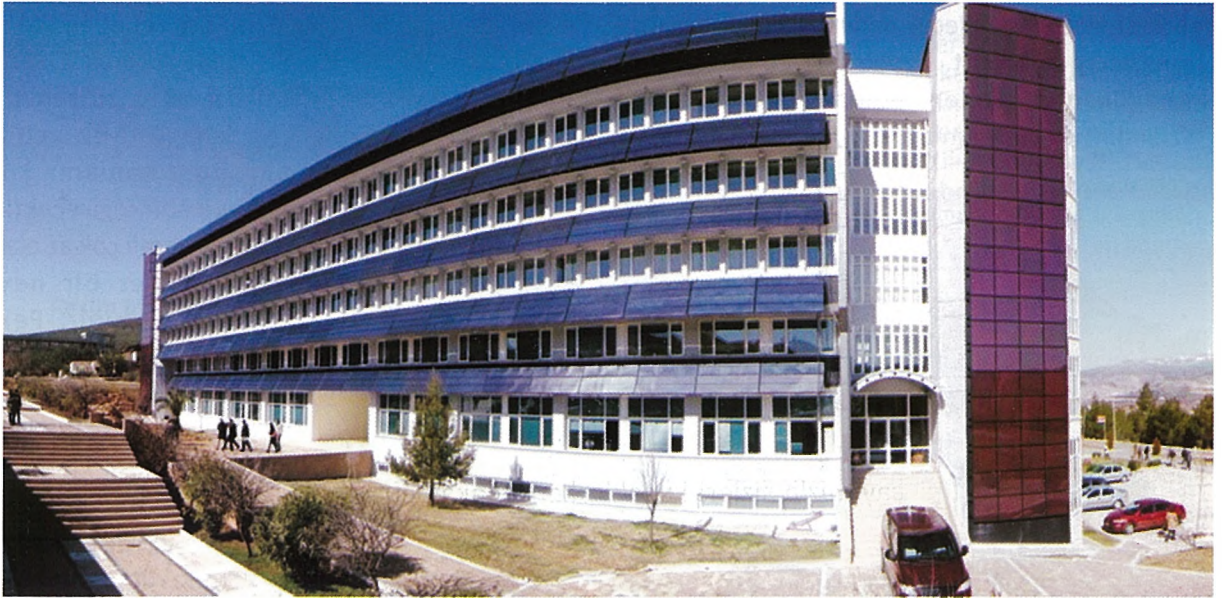
Resim 10 (Kaynak: solar-santral.com) Muğla Üniversitesi Rektörlük Binası'nda cephe kaplaması Amorf silisyum ince film modüllerle kurulu PV sistemi 40kWp kurulu güce sahiptir.
