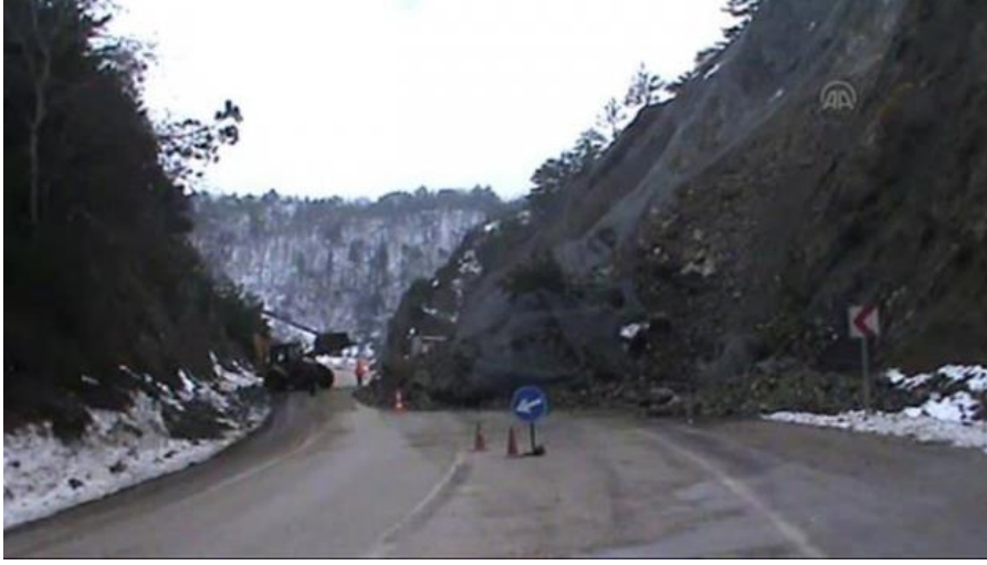
Bolu'daki heyelan yolu kapattı (kaynak: www.aa.com.tr )
