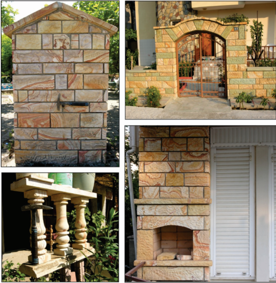
Şekil 6. Dekoratif amaçlı ve duvar kaplaması olarak kullanılan Çan taşları
