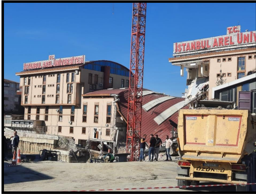
Fotoğraf 81: Arel Üniversitesi Binasında Meydana Gelen Yıkım Basın Açıklaması
