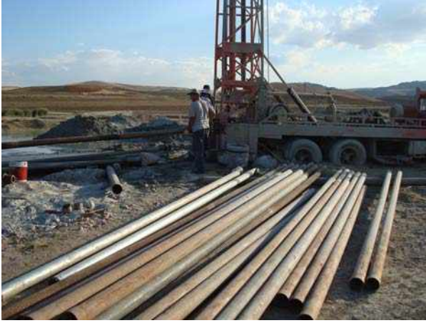
Resim 21. Kuyuda teçhiz işlemi. Picture 21. Supply process in the well.
