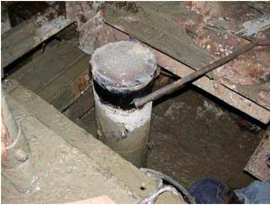
Resim 9. Tecrit borusunun kapatılması.
