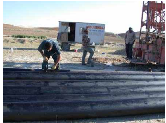
Resim 5. Tecrit borusunun hazırlanışı. Picture 5. The preparation of isolation pipe.
