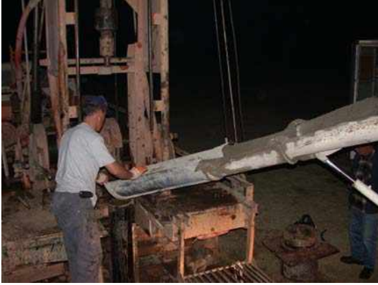
Resim 8. Tecrit için çimento dökümü.
