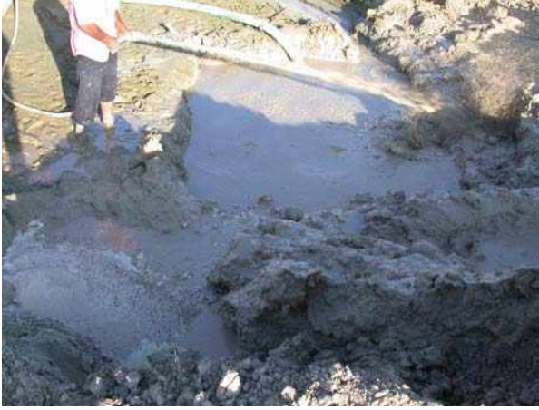
Resim 18. Yoğun çamur yapılması. Picture 18. Preparation of dense mud.
