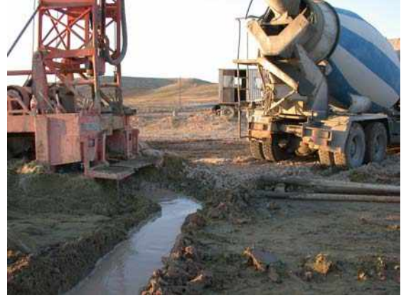
Resim 7. Mikser ile tecrit çimentosu temini. Picture 7. The supply of isolation cement with mixer.
