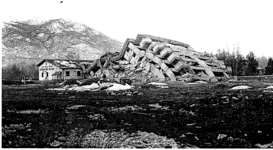
Resim-1. Konut Yapı Kooperatifi inşaatından hasar görüntüsü.
