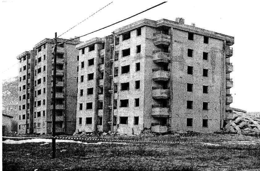
Resim-2. Konut Yapı Kooperatifi inşaatından hasar görüntüsü.. 3 katı yerine çökmüş bir bina...
