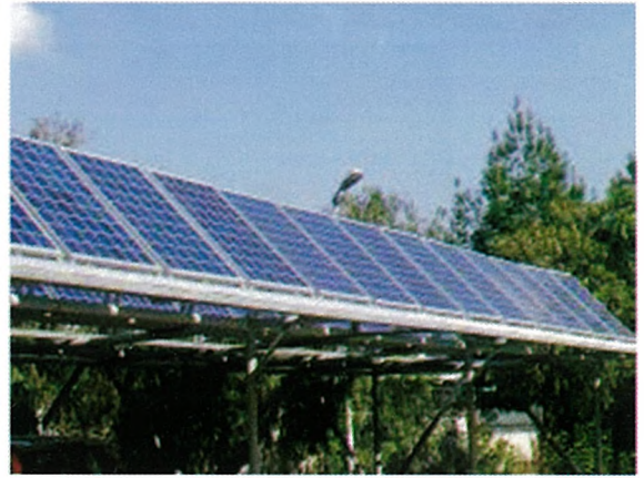
Ege üniversitesi- 24 kWp
