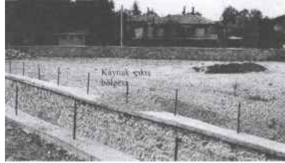
Şekil 5. Ulupınar kaynağı kaptajının genel görünümü
