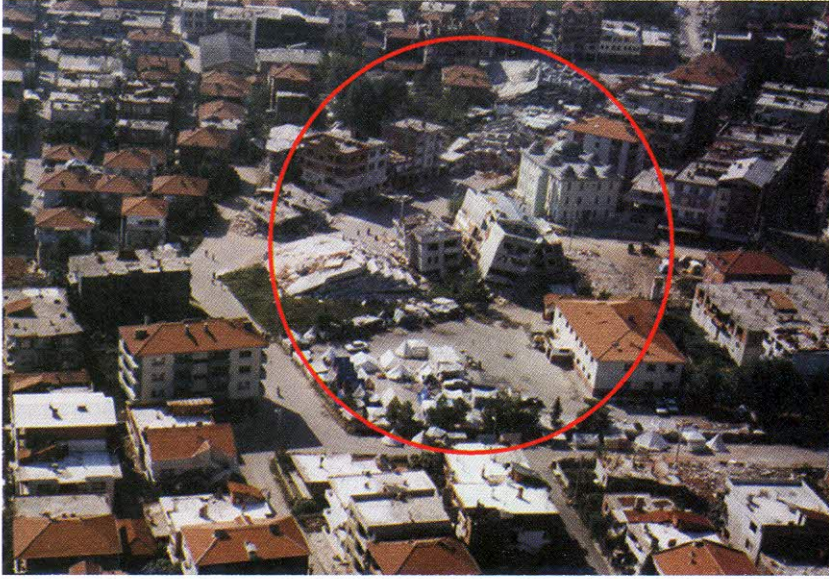
Adapazarı'nda yüzeyde sıvılaşmanın gözlenemediği, ancak sıvılaşma nedeniyle yana yatmış yapıların bulunduğu bir semt (Fotoğraf: Ömer Aydan)
