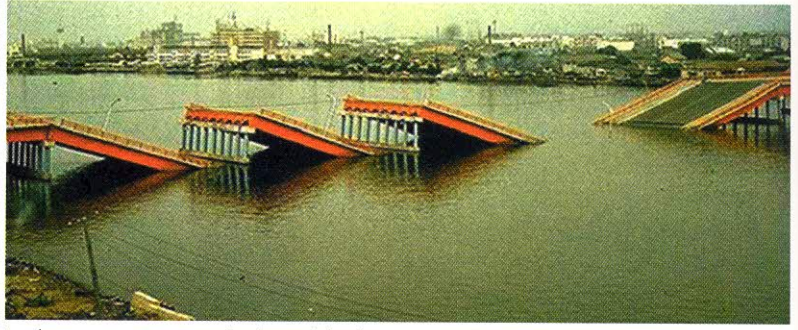
1964 Niigata depreminde (Japonya) sıvılaşma sonucu yana yatmış binalar ve yıkılan Showa Köprüsünden bir görünüm
