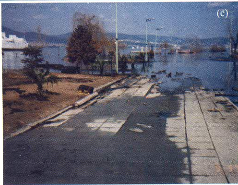
Yanal yayılma hareketine tipik örnekler: (a) Ceyhan Nehri kıyısında (1998) Adana-Ceyhan Depremi ve (b) Sakarya Nehri kıyısında (1999) Kocaeli Depremi) yanal yayılma ile ilişkili şev hareketleri (c) Gölcük-Kavaklı'da denize sürüklenmiş kıyı ve sıvılaşan kum
