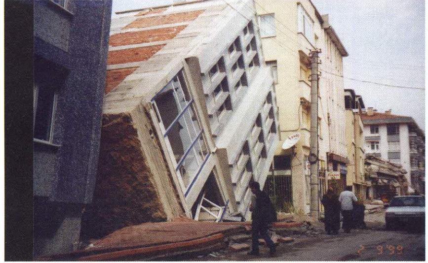
Adapazarı'nda sıvılaşma nedeniyle devrilmiş bir bina
