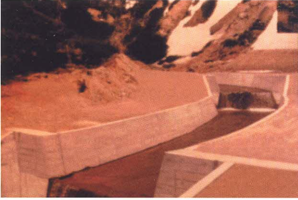
Şekil 11. Madenin bulunduğu yüzeyden geçen küçük akarsu yatakları beton ile kaplanarak, yüzey suyunun yeraltına geçmesi önlenmektedir.
