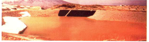
Şekil 9. Nötürleştirme sonucu oluşan sarı renkli sedimanlar atık havuzunda biriktirilir.
