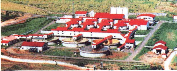
Şekil 2. Matsuo Nötürleştirme Tesisi, Iwate, Japonya.
