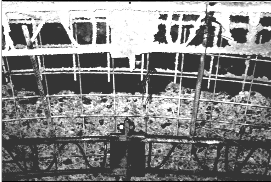
Şekil 1. Neojen çökellerinde açılan tünelde 80 cm ilerleme sonrası yeni koyulmuş 1. kat hasırçelik ve iksa. Tavana bakış. Az tutturulmuş çakıllı siltli nemli kum üzerinde fotoğrafta görülmeyen ve zeminin içine sürülmüş 27 adet şemsiye kemer için enjeksiyonlu boru vardır.
